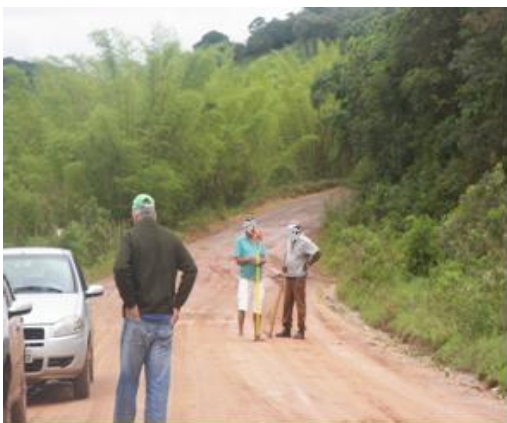
Foto 5 – Falta de EPI's. Via sem Sinalização Fonte: o autor
