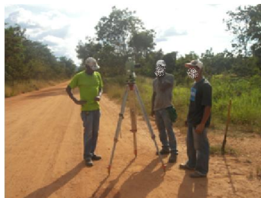
Foto 6- Falta de EPI's. Via sem sinalização Fonte: o autor
